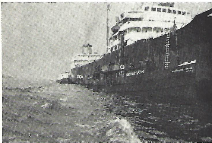
„Wheeler boat” langsij voor levering van stoom, lucht en licht.
